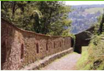
Nördlicher Wehrgang mit Blick Richtung Donautal
