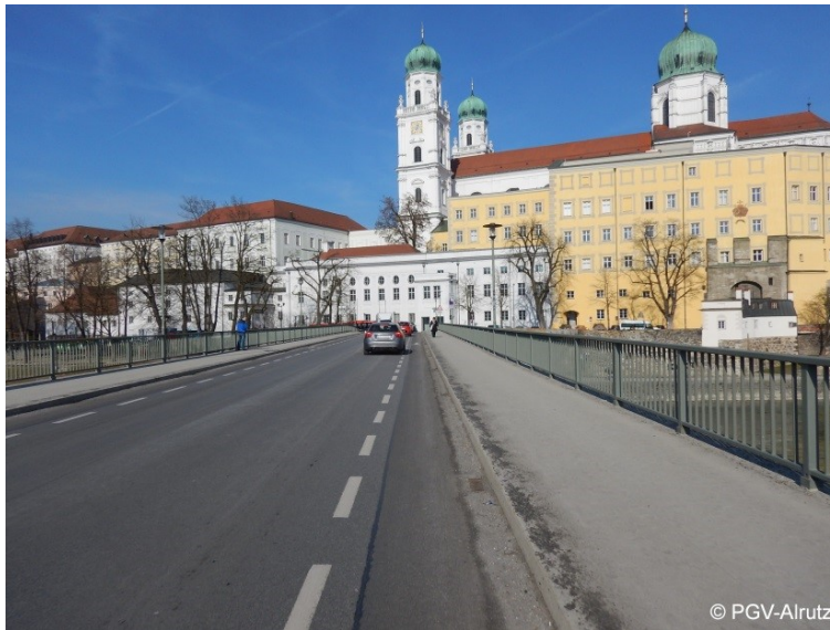
Abb. 6-11: Beidseitige Schutzstreifen (Passau, Marienbrücke)
