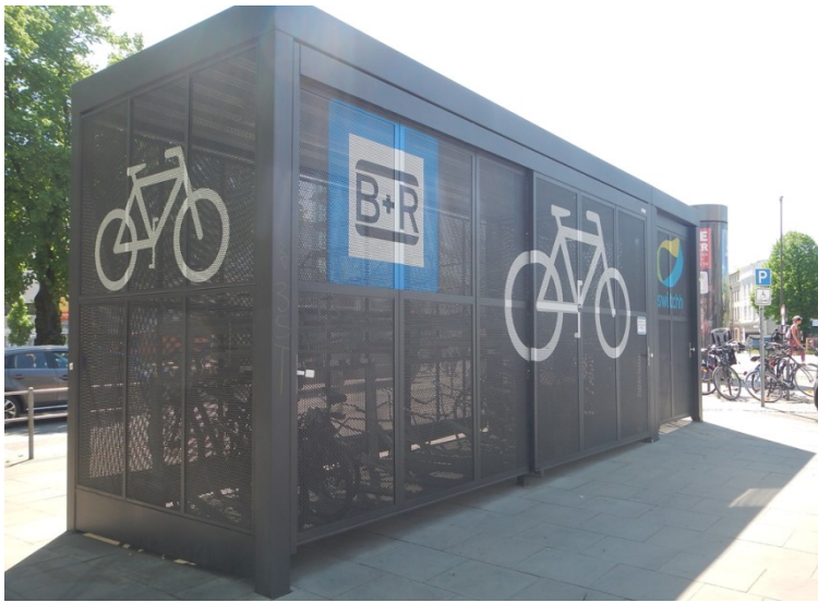
Abb. 7-9: Beispiel Sammelschließanlage Hamburg Altona
