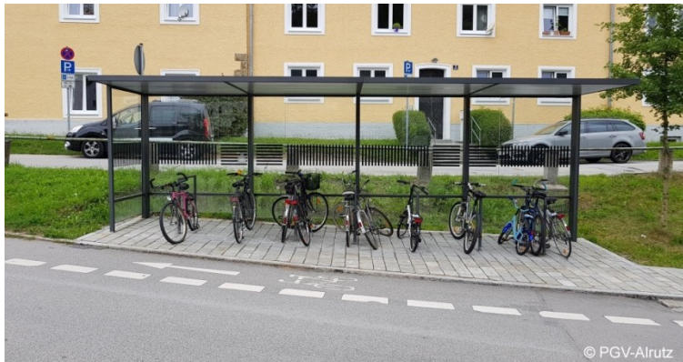
Abb. 7-17: Überdachte Abstellanlage am Ilzparkhaus
