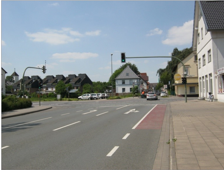
Abb. 6-18: Vorbeifahrstreifen in einer signalisierten Knotenpunktzufahrt (Bielefeld)
