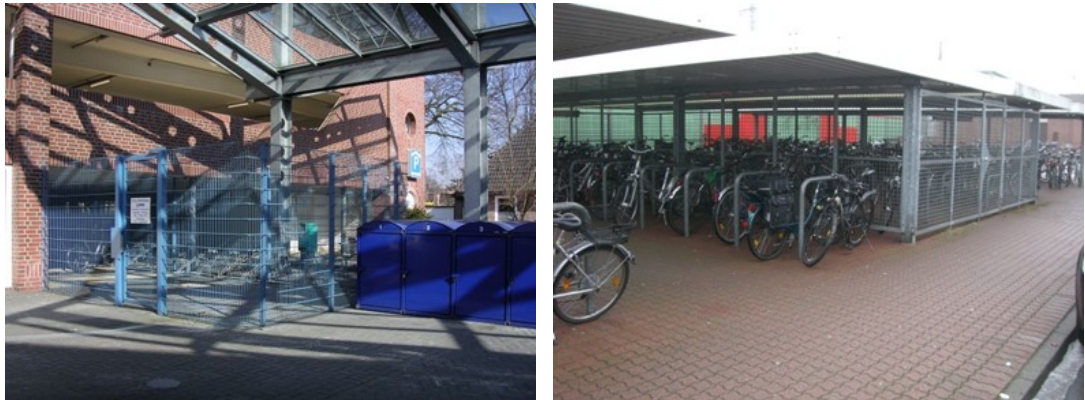
Abb. 7-7: Beispiele für Fahrradabstellanlagen mit Umfriedung in Leer (links) und Lehrte (rechts)
