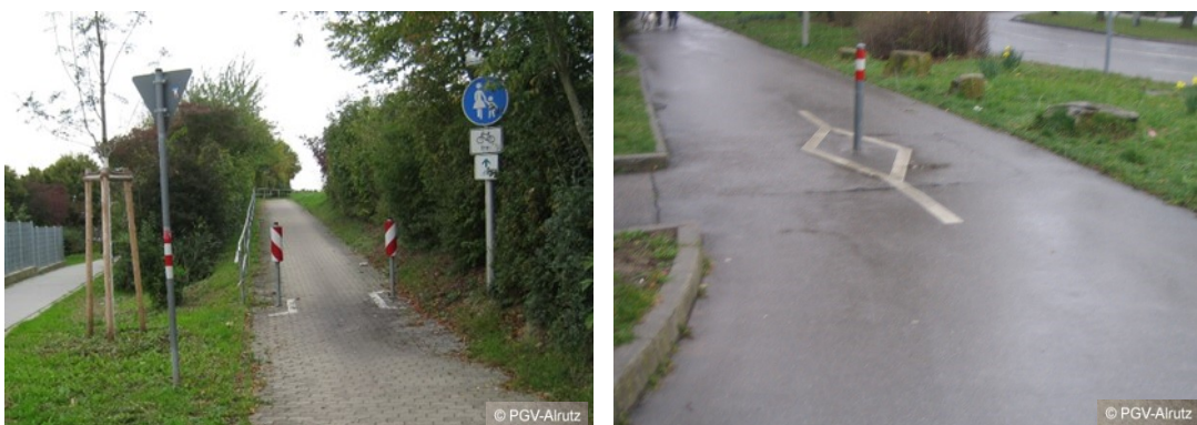
Abb. 6-29: Beispiele für beidseitige Poller mit Bodenmarkierungen in Bruchsal (links) und mittiger Poller mit Bodenmarkierung in Stuttgart (rechts)
