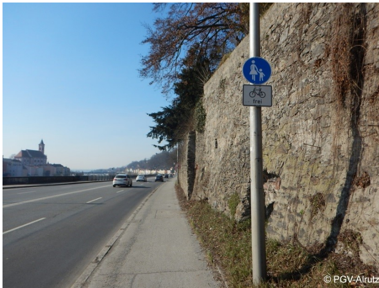
Abb. 6-14: Gehweg, Radverkehr frei in unzureichender Breite (Passau, Angerstraße)
