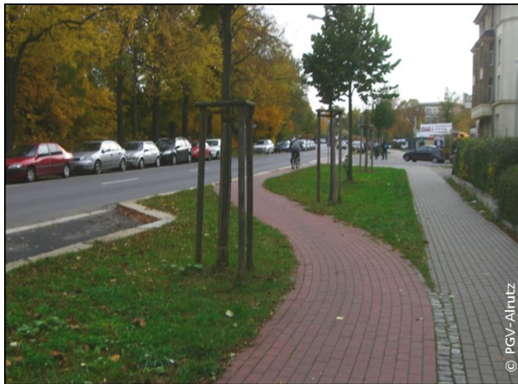
Abb. 6-15: Radverkehr wird im Vorfeld des Knotens an den Fahrbahnrand und damit ins Sichtfeld des Kfz-Verkehrs geführt
