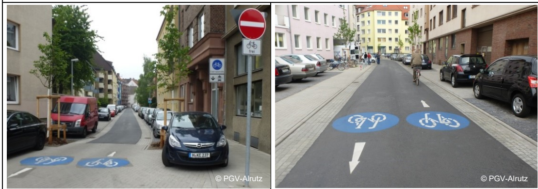
Beispiel Hannover Runde Piktogramme in Blau und Richtungspfeile im Straßenverlauf. Die Rinnen zwischen der asphaltierten Fahrbahn und den Parkständen sind farblich abgesetzt gepflastert und dienen als Sicherheitstrennstreifen.
