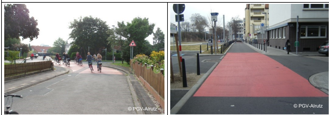
Beispiel Burgdorf (links) und Mannheim (rechts) Bevorrechtigung an Einmündungen im Zuge einer Fahrradstraße durch flächige Markierung und Vz 301 StVO
