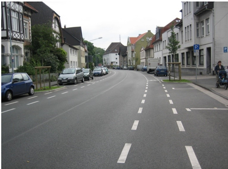
Abb. 6-10: Schutzstreifen mit Sicherheitstrennstreifen zu parkenden Kfz (Lemgo)
