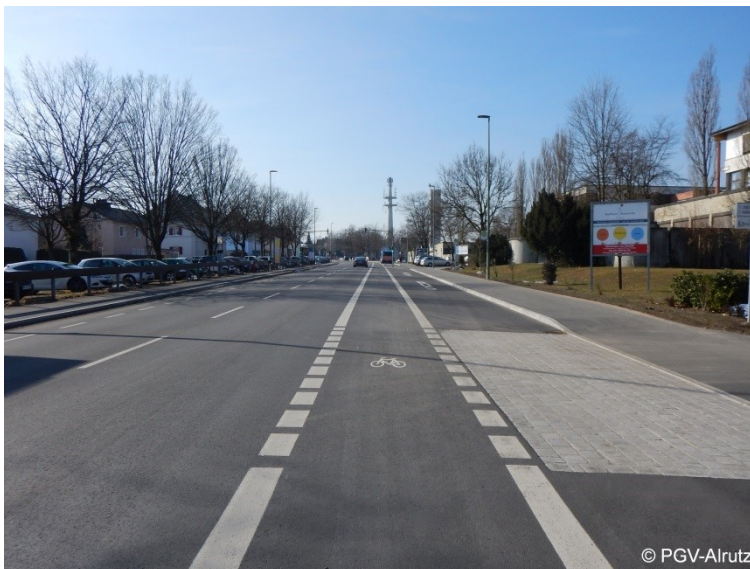
Abb. 6-8: Radfahrstreifen (Passau, Neuburger Straße)
