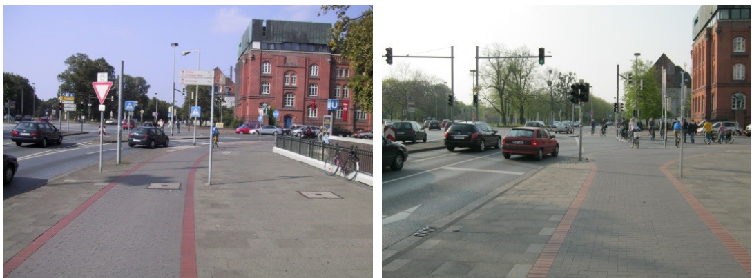
Abb. 6-19: Rückbau und Signalisierung eines konflikträchtigen freien Rechtsabbiegefahrstreifens in Hannover (links vorher, rechts nachher)
