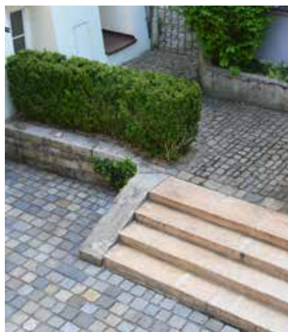
Vorplatz mit Granitblockstufen / Großsteinpflaster
