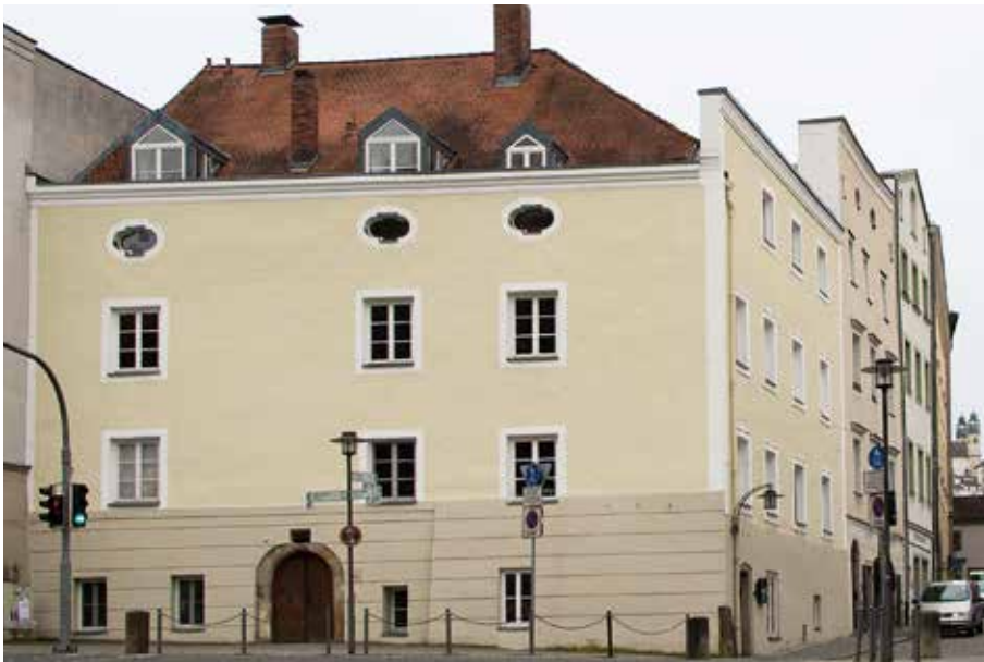
Kubisches Gebäude mit hochgezogenen Attikamauern
