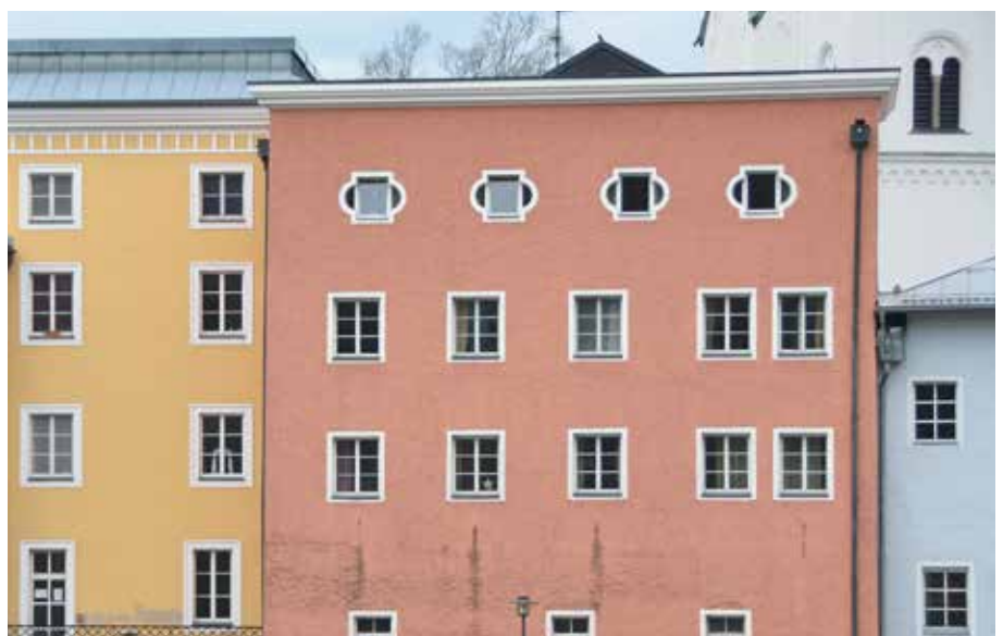
Fassade mit sogenannten Ochsenaugen-Fenstern im Dachgeschoss
