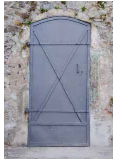
Bruchsteinwand mit Metalltüre
