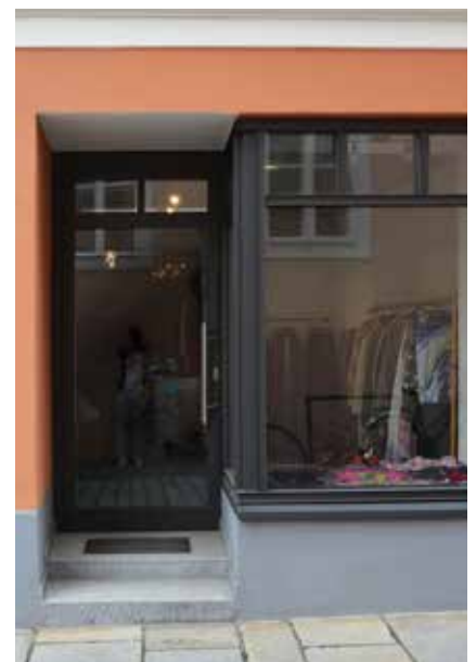
Ladentür/Schaufenster-Kombination in Metall
