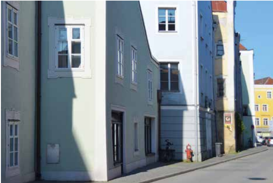
Rücksprünge in der Häuserzeile zur besseren Belichtung, Schmiedgasse
