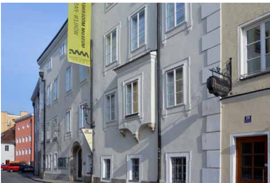
Typische Fassade mit Passauer Fenstern
