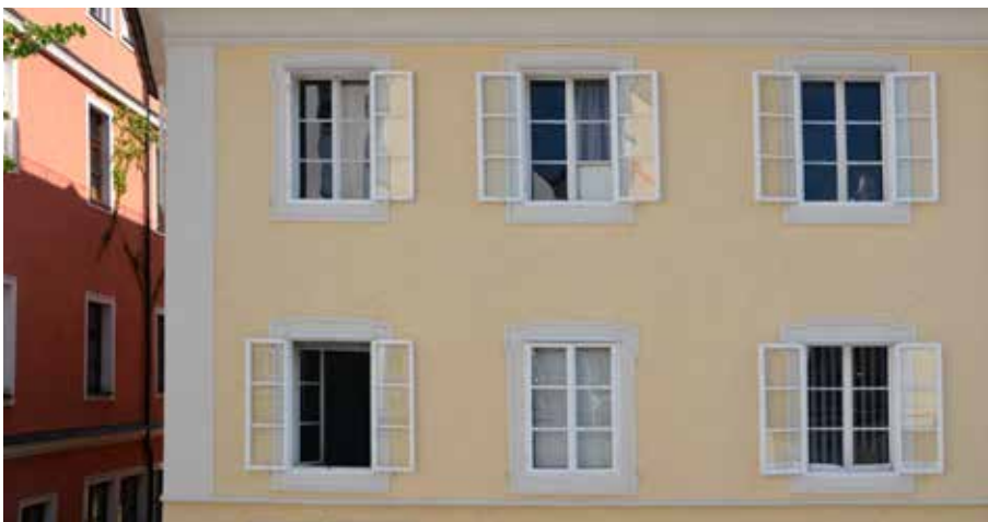
„Passauer Winterfenster“, nach außen aufschlagend
