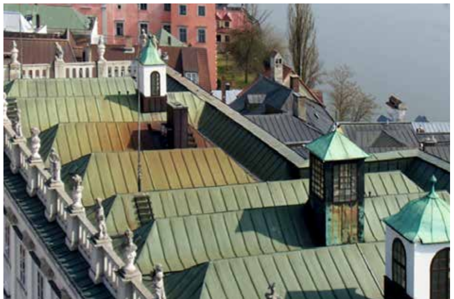
Dachdraufsicht Grabendächer
