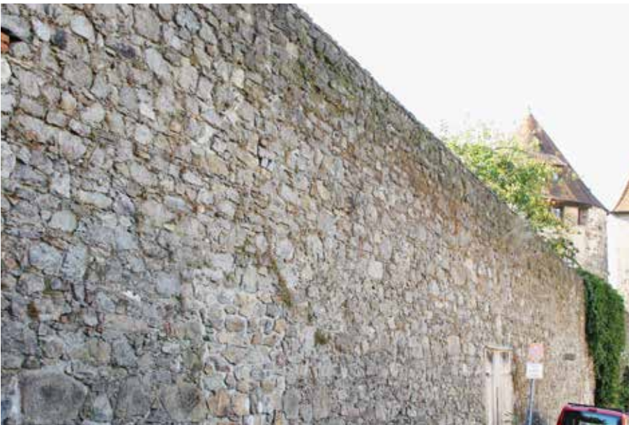
Stadtmauer (Bruchsteinmauer) in der Innenstadt
