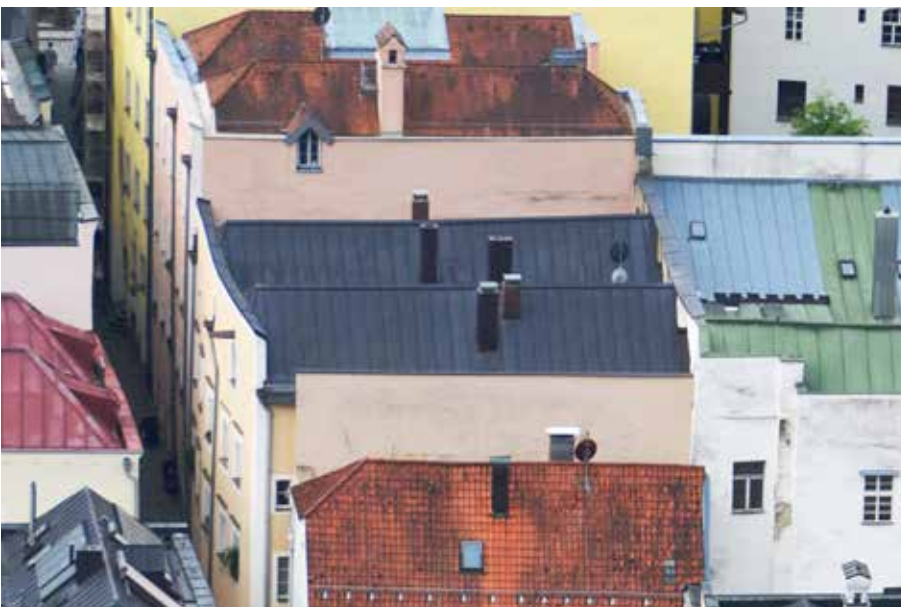
Dächer hinter hochgezogenen Attikamauern
