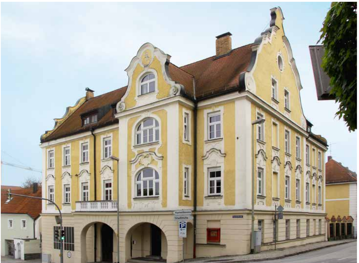
Satteldach mit vorgeblendetem Schweifgiebel
