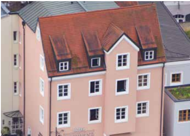
Satteldach mit abgeschleppten Gauben und 3-geschossigem Zwerchhaus
