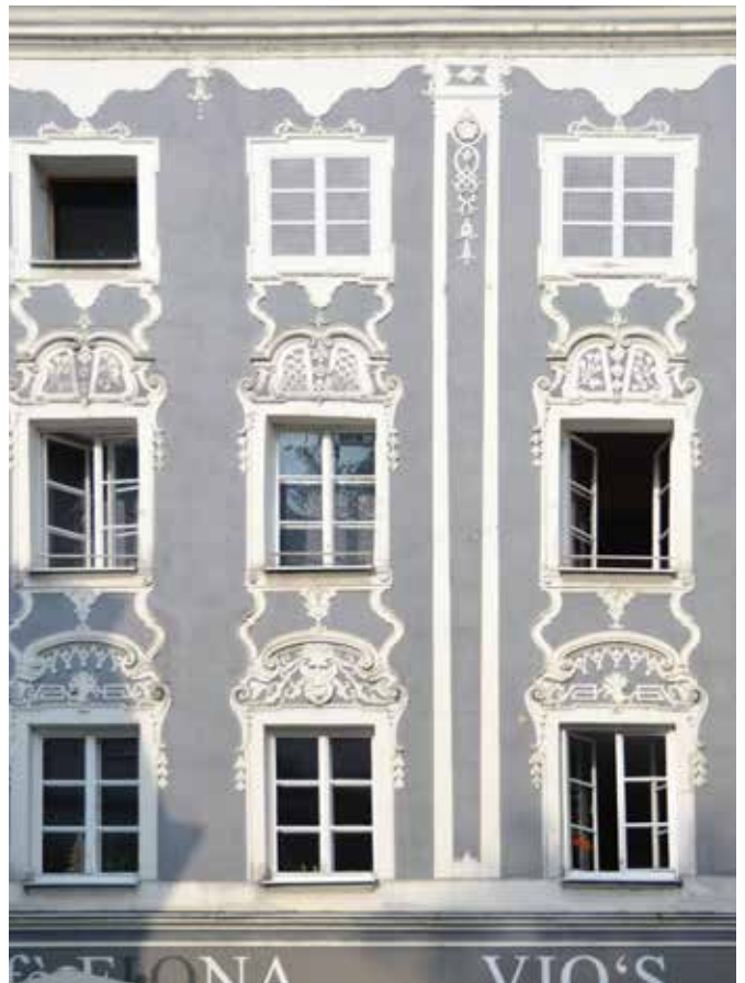
Reich stuckierte Fassade mit aufgemalten Blindfenstern
