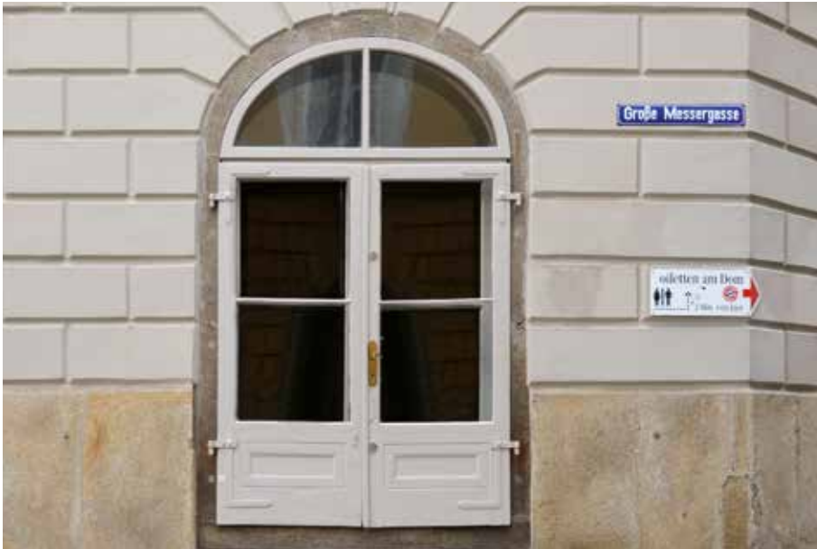
Erdgeschoss mit Putzrustika
