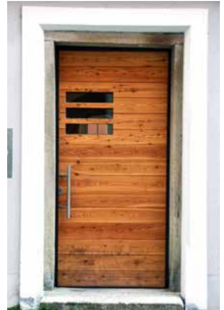
Neu gestaltete Eingangstüre
