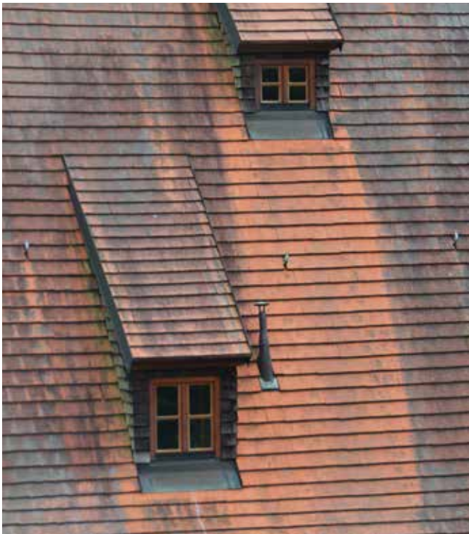
Abgeschleppte Dachgaube
