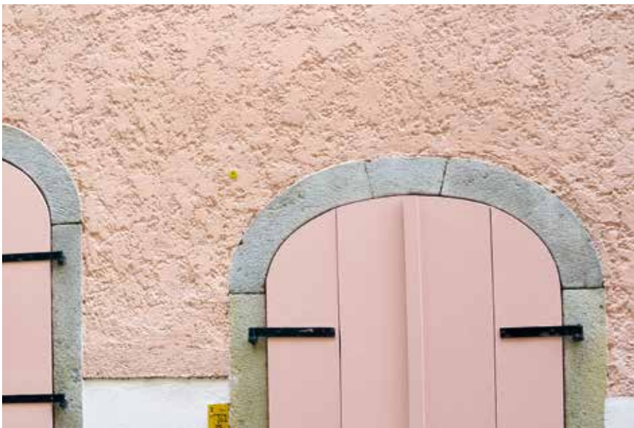
Fassade mit verriebenem Wurfputz
