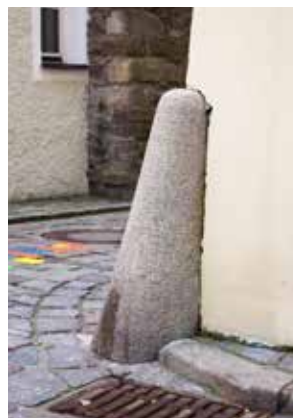
Radabweiser, Ecke Höllgasse/Steiningergasse
