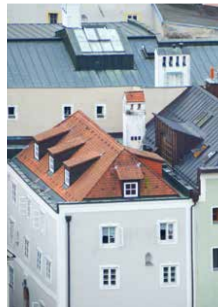
Walmdach mit Schleppegauben
