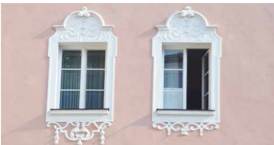
Fenster mit stuckiertem Bandelwerk
