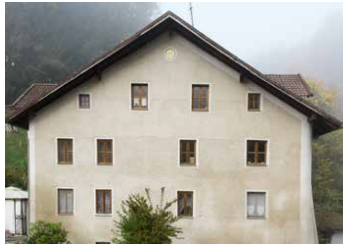
Satteldach mit geringem Dachüberstand (alte Mühle)
