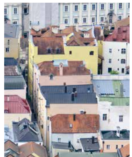
Dachdraufsicht im Bereich Altstadt
