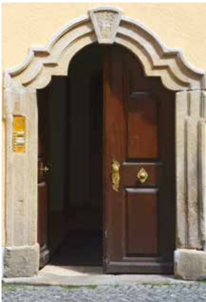
Aufwändig gestaltetes Granitportal
