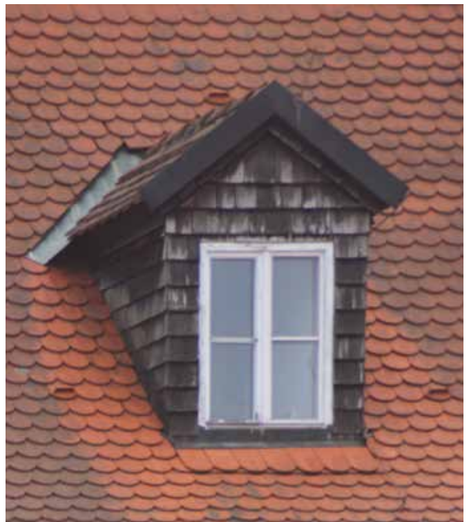
Dachgaube mit Holzschindeln verkleidet
