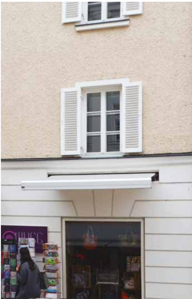
Schaufenster mit einziehbarer Stoffmarkise (Markisenkasten bündig in die Fassade eingelassen)
