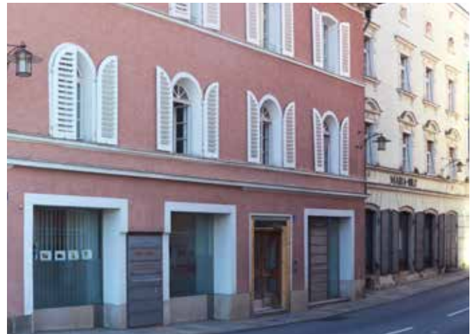
Fassade mit Fensterläden (Holzlamellen)
