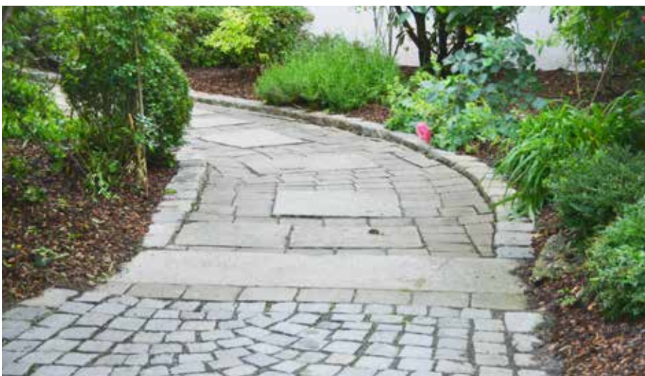
Formatwechsel bei Pflasterweg mit Granitsteinen/-platten
