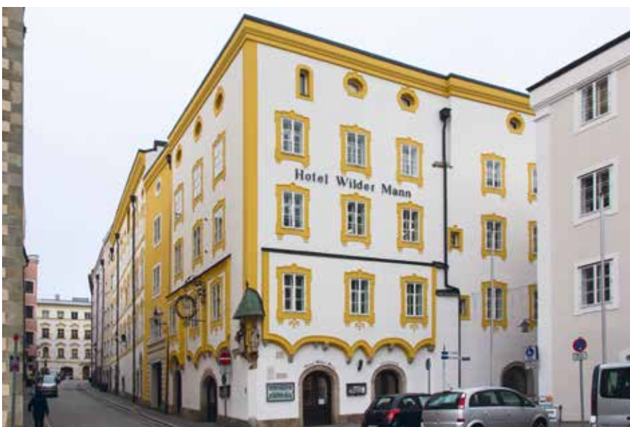
Hotel / Museum, bestehend aus mehreren Gebäuden
