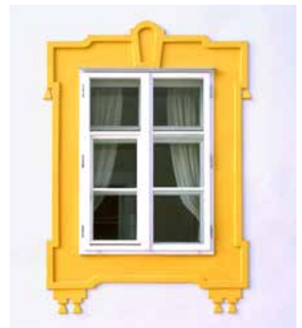
Typisches Passauer Kastenfenster mit nach außen aufschlagenden Flügeln
