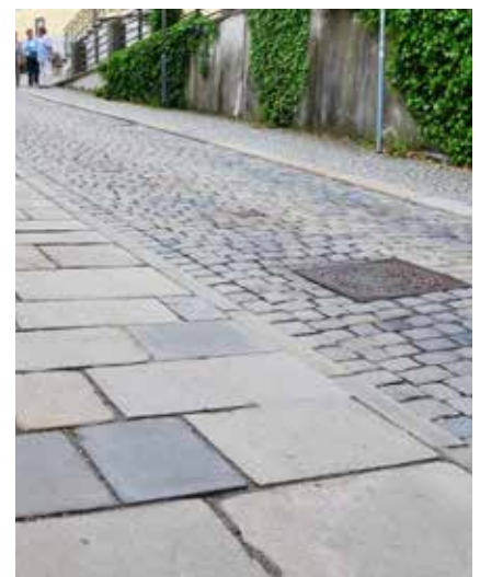
Gehweg mit großformatigen, alten Gredplatten (Granitplatten)
