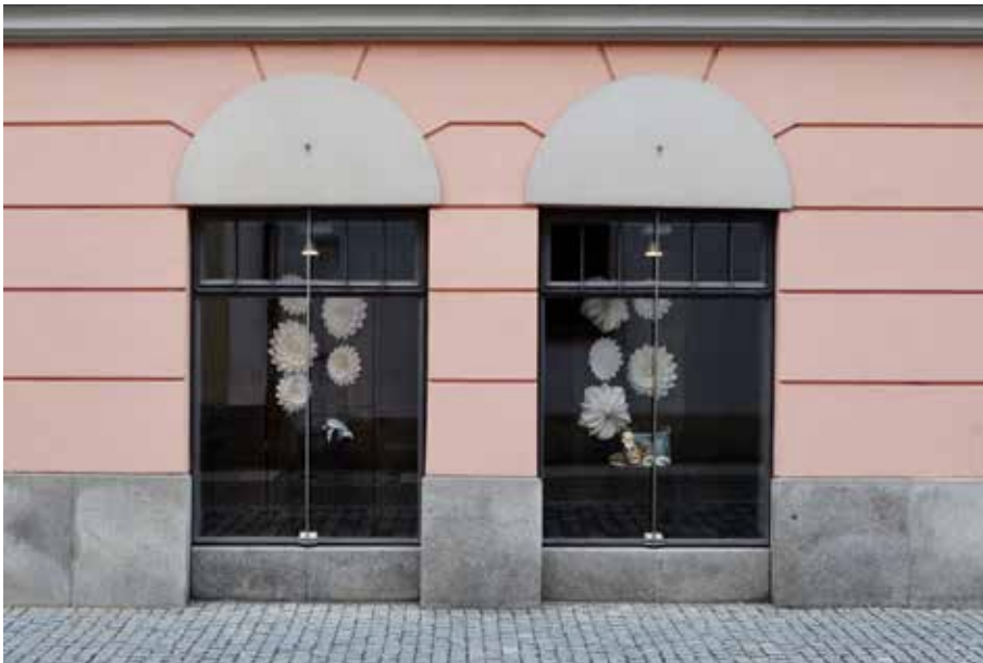
Schaufenster aus Metall durch Mauerwerkspfeiler gegliedert
