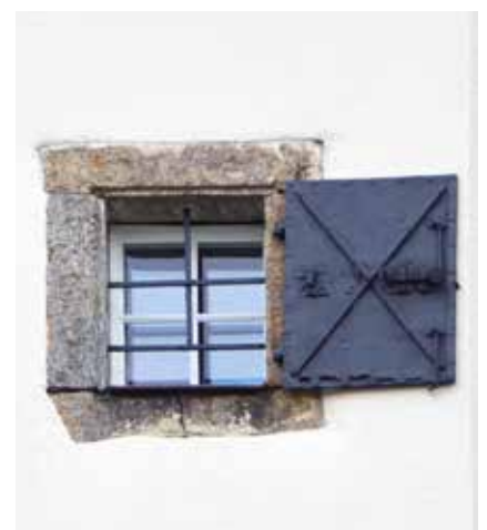
Vergittertes Fenster mit Eisenladen
